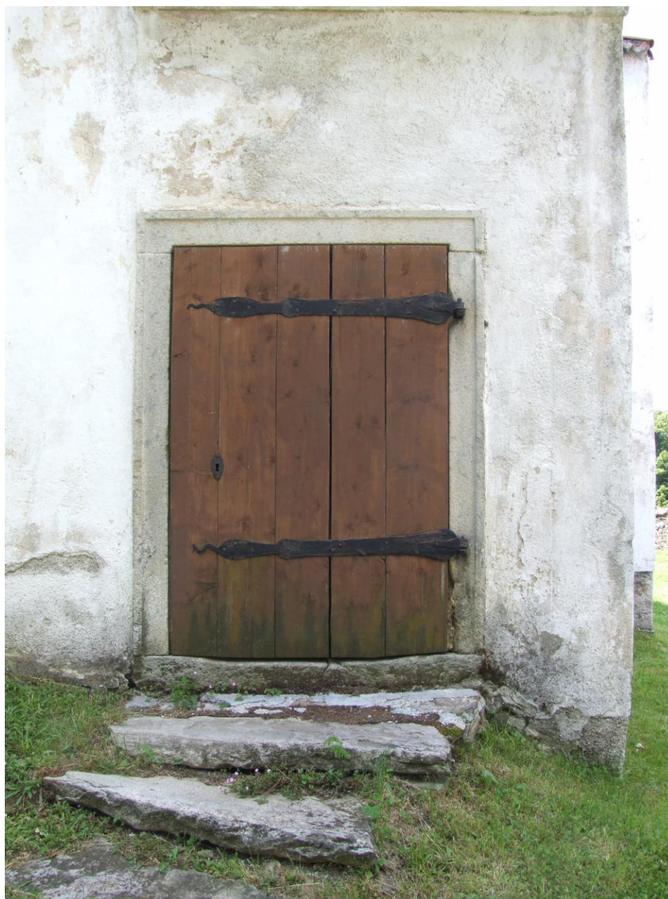
Tür in den Kirchturm.
