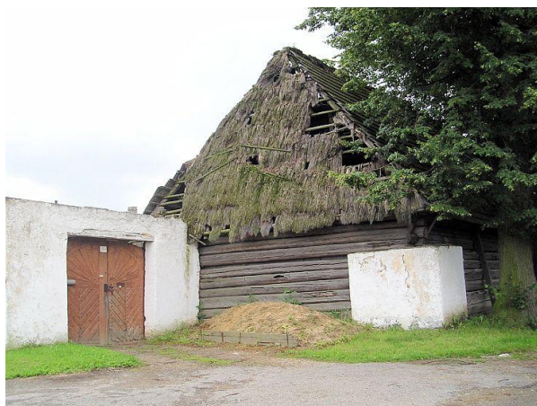
Malovice – roubená stodola s doškovou střechou (zdroj Oldřich Petrášek)
